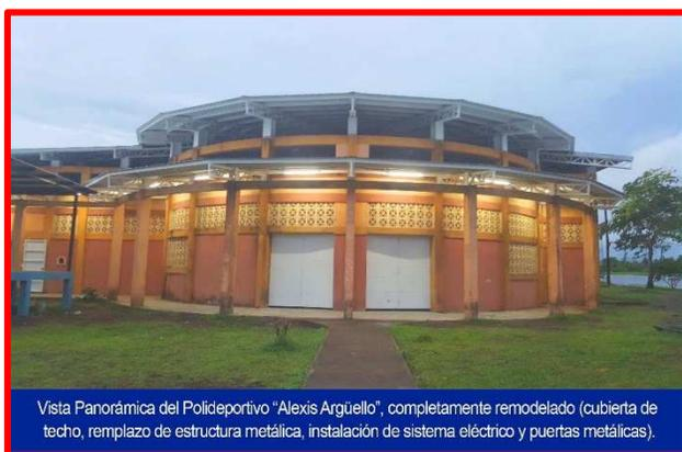
Vista Panorámica del Polideportivo “Alexis Arguello”, completamente remodelado (cubierta de techo, remplazo de estructura metálica, instalación de sistema eléctrico y puertas metálicas).
